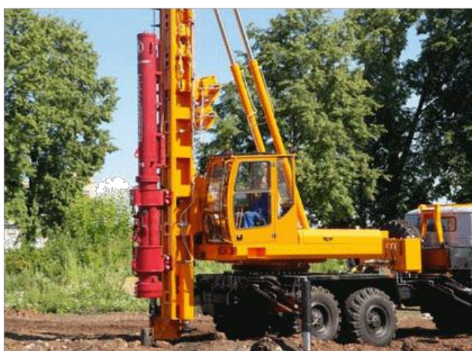
Рис.15. Забивка свай-опор бурильно-сваебойной машины БМ-811
